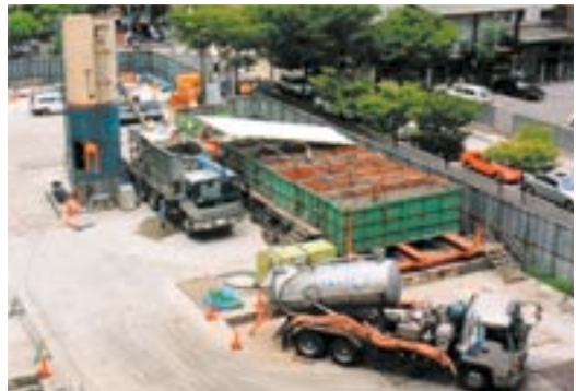
スラリーモルタル施工風景
