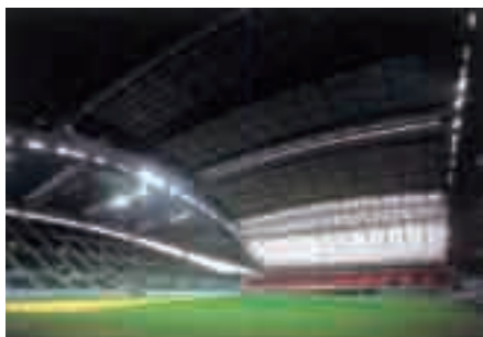
R屋根 / 直立壁
