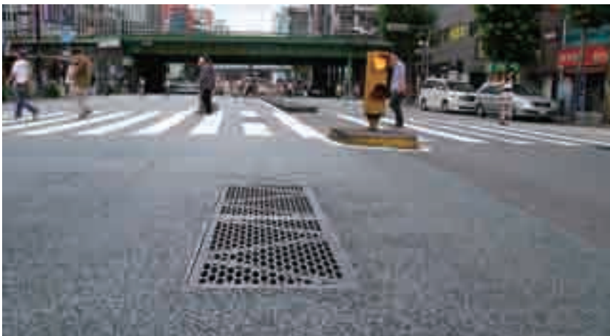
東京・日比谷の晴海通りの中心部に施工されている。
