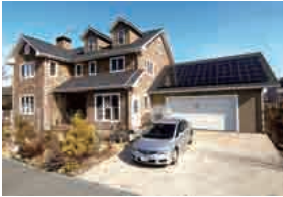
一般住宅設置事例
