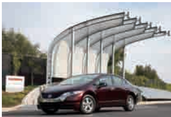
太陽電池式水素ステーション
